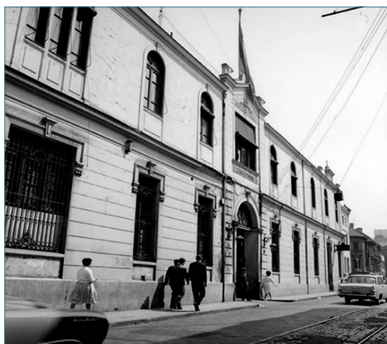
Figura 3. Edificio de la Asistencia Pública después de sus ampliaciones realizadas en 1922 y 1923.
